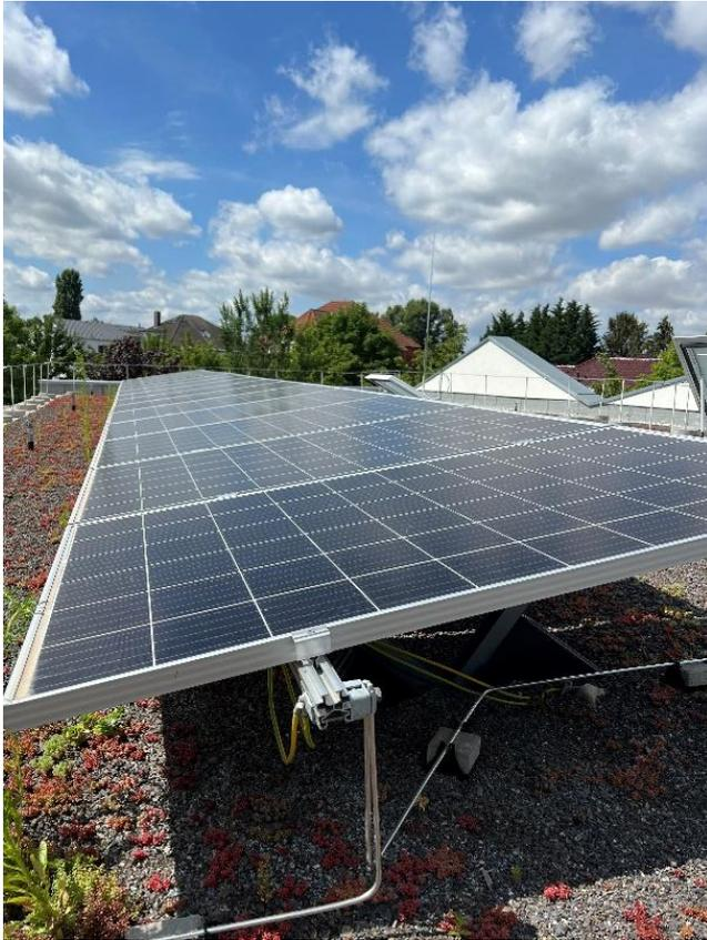
Abbildung 2: Foto PV-Anlage mit Begrünung auf dem Dach der KITA Wolkenburg
